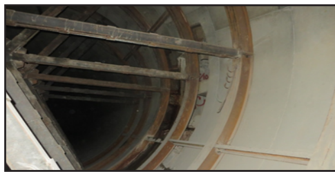
شکل (۹): آهن کشی سگمنت های اطراف محل کراس پاساژ جهت جلوگیری از پلهای شدن آنها در خط ۱ مترو شیراز
