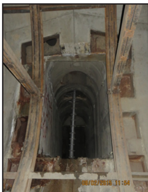
شکل (۸): تخریب سگمنت کراس و احداث گالری ارتباطی بین دو تونل در خط ۱ مترو شیراز
