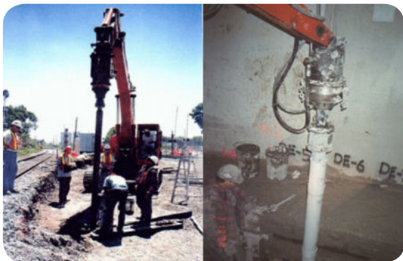
شکل (۳): اجرای ریز شمع در راه آهن کانادا
