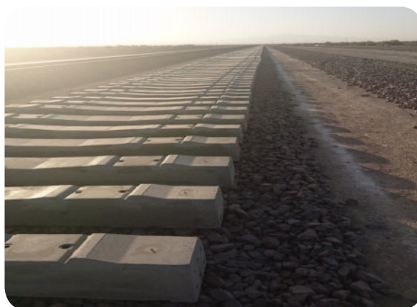
شکل (۹): بالاست ریزی پوش اول و تراورس گذاری بلاک- در قطعه
