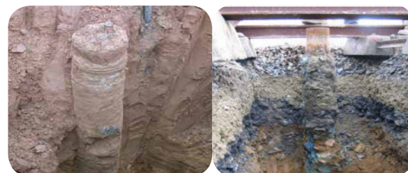
شکل (۱۰): نمونه ستون های اختلاط عمیق اجرا شده در سایت
