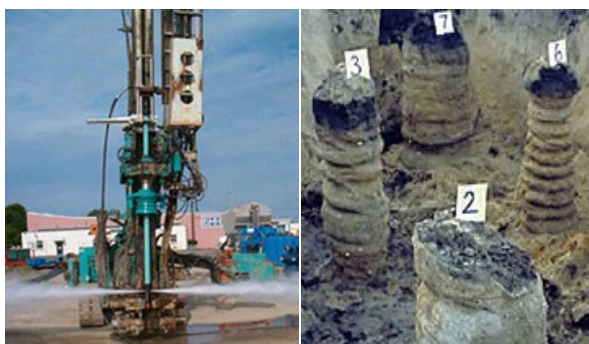
شکل (۴): دستگاه تزریق تحت فشار و نمونه ستون های اجرا شده
