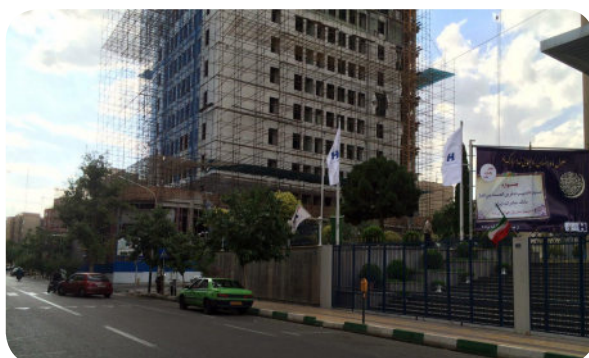
شکل (۶): پروژه برج غدیر در حال احداث بر اساس طرح نهایی
