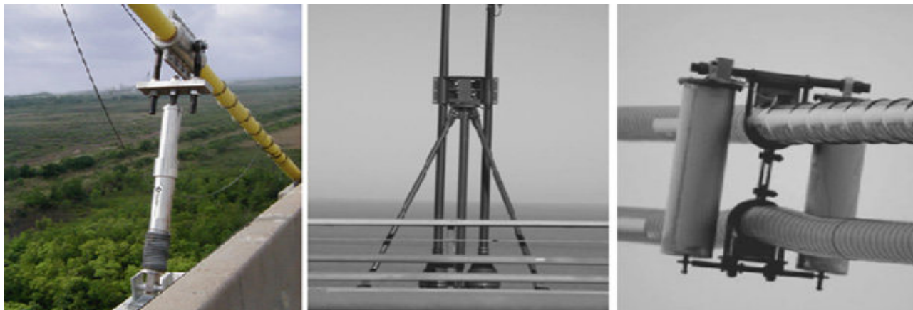
شکل (۹): استفاده از مستهلک کننده به منظور افزایش ظرفیت استهلاک انرژی کابلها
