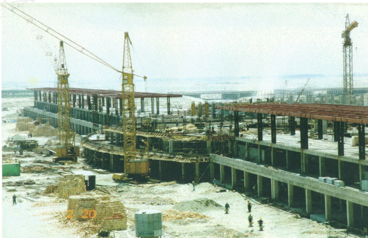
شکل شماره (۱۹): اجرای طرح ترمینال مسافری (بخش اپرون)
