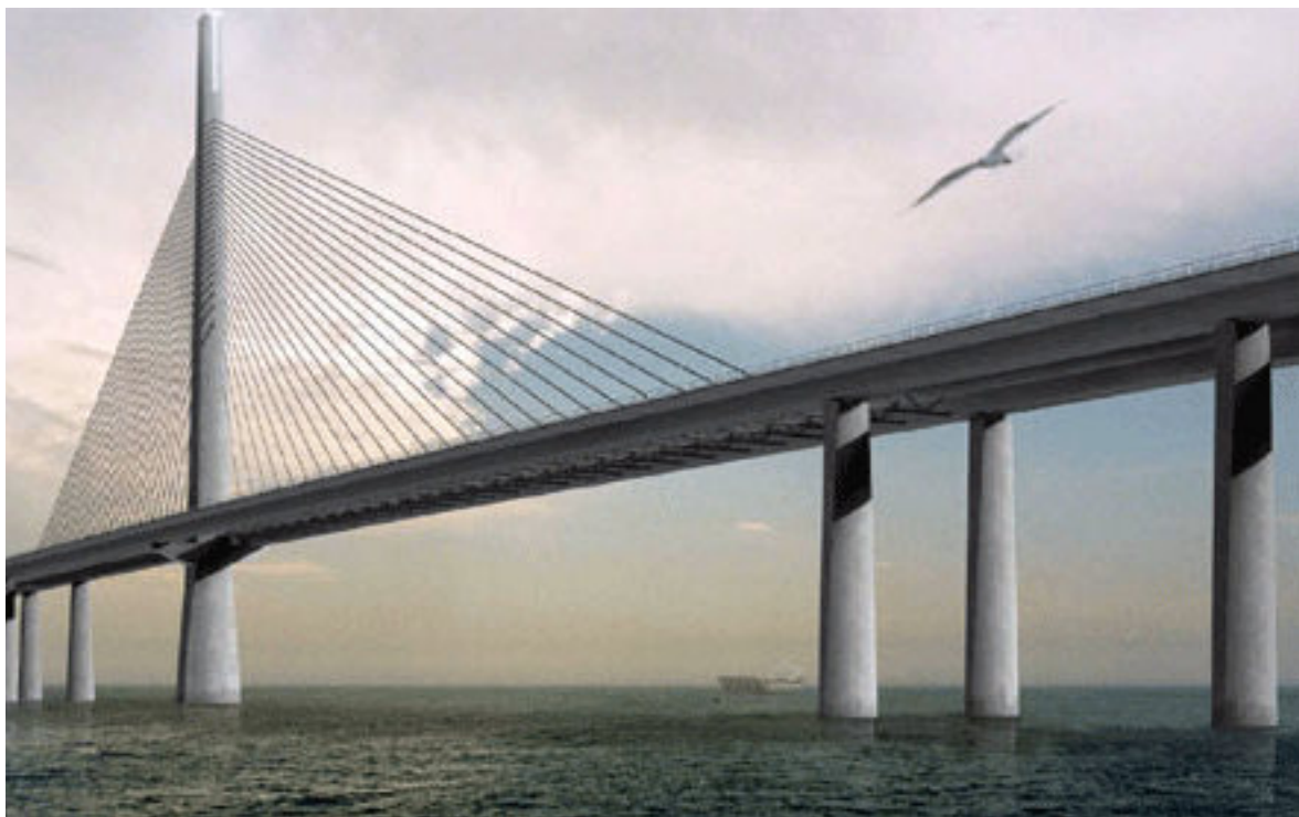
شکل شماره (۹): تصویر سازه پل بحرین به قطر
