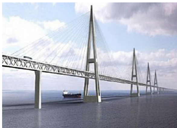
شکل شماره (۷): نمای کلی پل فهارن
